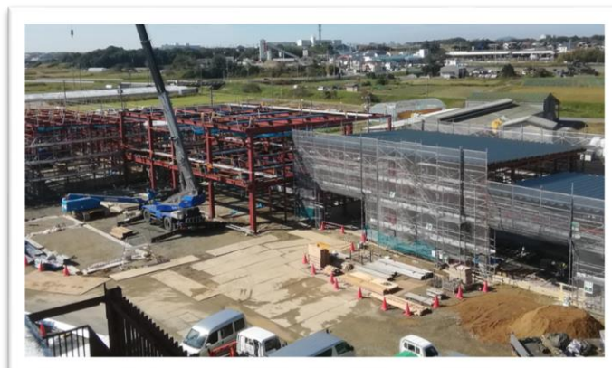
▲建設中の経済部管理棟・自動車整備工場・農業機械整備工場
