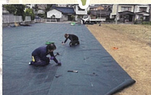
シート敷き込み (固定)
