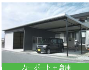
内部：最大10mまで間柱なし→ラチス梁
