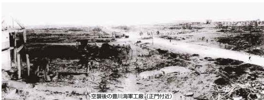
破壊された工場
