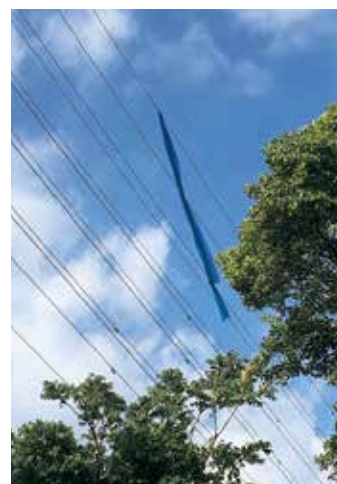
電線への防風網付着状況写真
