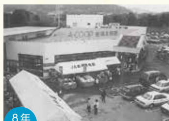
8年 11月 Aコープ豊橋北部店 (現・産直プラザ石巻)竣工(北)
