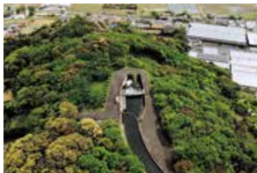
二川サイホン（入口）
